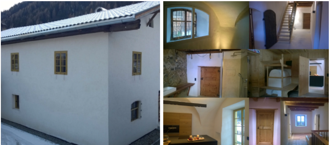
Abb. 4: Knablhof, nach Sanierung
