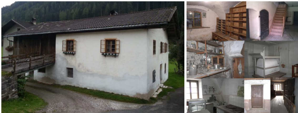
Abb. 3: Knablhof, vor Sanierung – Südtirol
