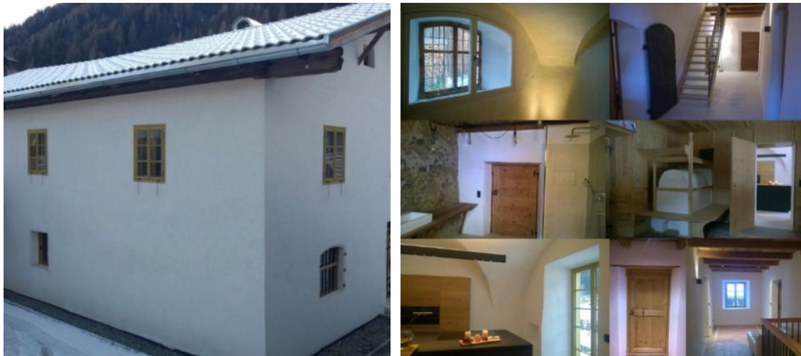
Abb. 4: Knablhof, nach Sanierung
