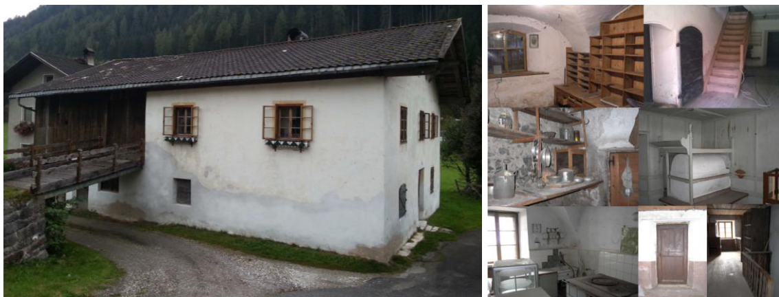
Abb. 3: Knablhof, vor Sanierung – Südtirol
