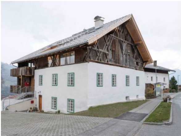
Abb. 11: Kasperhof, Südost nach Sanierung 2018, Bundesland Tirol 18
