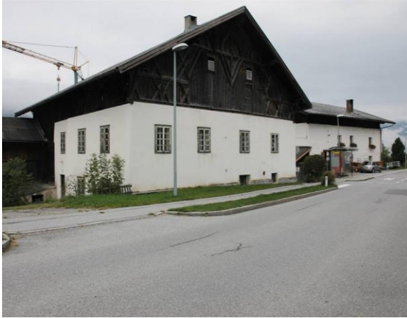
Abb. 10: Kasperhof, Südost vor Sanierung 2017 – Bundesland Tirol 17
