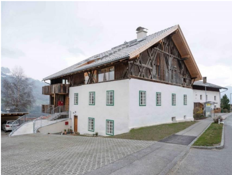
Abb. 18: Kasperhof, Südost nach Sanierung 2018 – Bundesland Tirol 45
