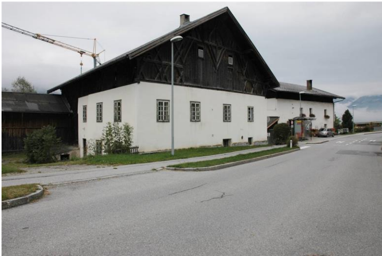
Abb. 17: Kasperhof, Südost vor Sanierung 2017 – Bundesland Tirol 44
