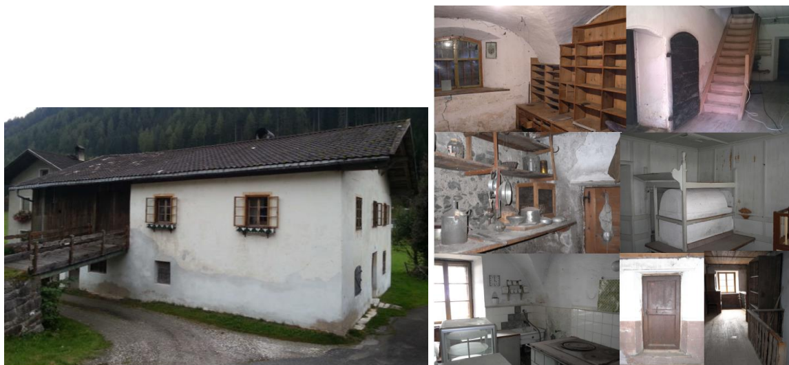
Fig. 3: Maso Knablhof, prima della ristrutturazione – Provincia di Bolzano
