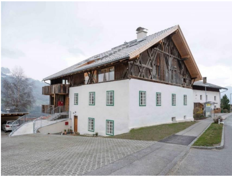
Fig. 18 Kasperhof, lato sud-est dopo la ristrutturazione, 2018 – Land Tirol 44
