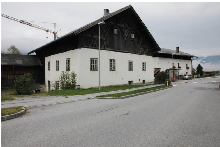
Fig. 17 Kasperhof, lato sud-est prima della ristrutturazione, 2017 – Land Tirol 43
